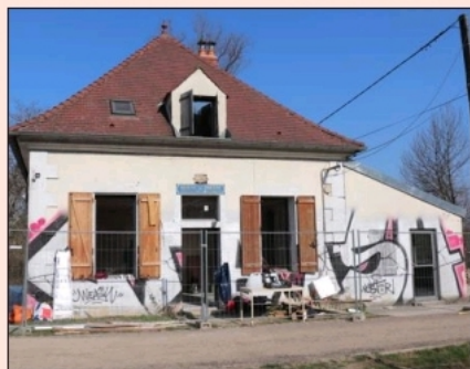
La maison éclusière de Bruant fait l'objet d'une réhabilitation pour devenir la guinguette culturelle Au Maquis. Photo LBP/N. D.
