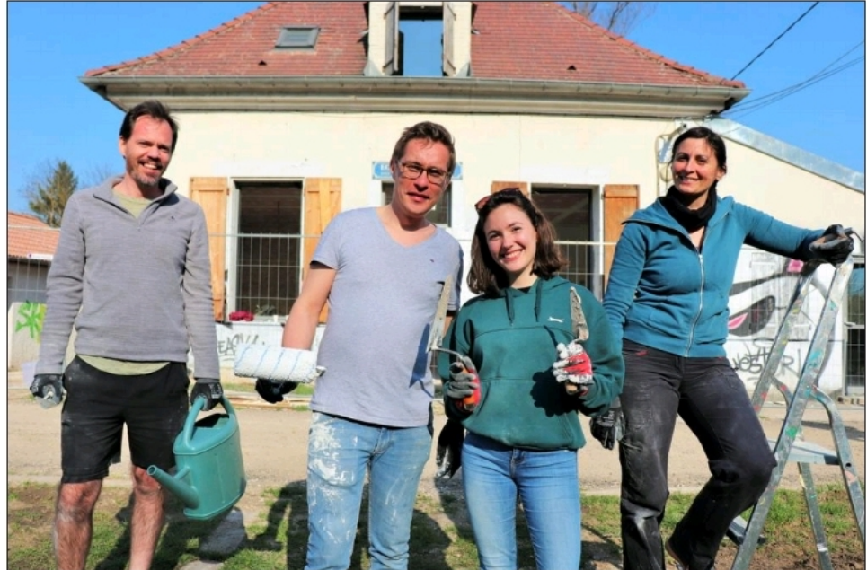
Des bénévoles ont prêté main-forte à la maison éclusière Bruant, samedi et dimanche, à l'occasion d'un chantier participatif. Photo LBP/N. D.
